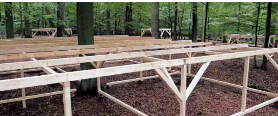
*Abgeschirmt: Mit halb offenen Dächern unterhalb der Baumkronen simulieren die Forscher Trockenheit im Wald. Das Bild zeigt, wie die Dächer gebaut werden.*
